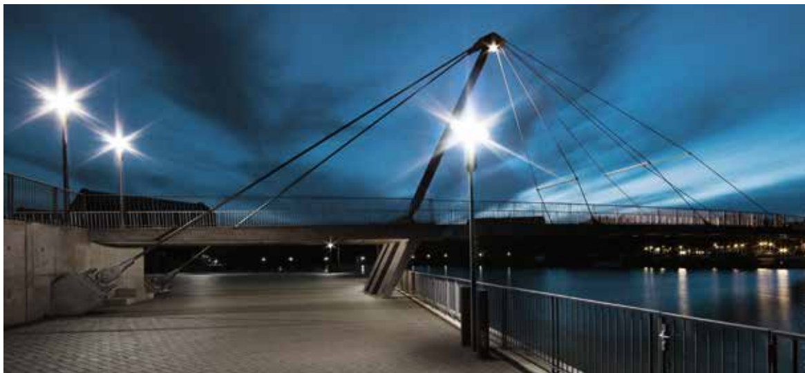
1.2 Eclairage des ponts.
