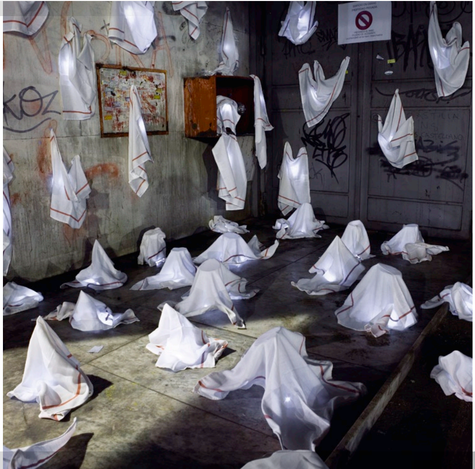
„Cleaning that shines“: Die weißen Tücher konnten zwar nicht das Telefonica-Gebäude reinigen, aber deutlich auf den heruntergekommenen Zustand hinweisen.
