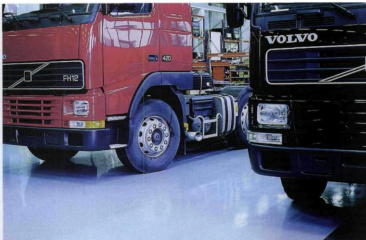
Wylewka polimerowa jest odporna na działanie środków chemicznych i obciążeń dynamicznych. Posadzki można nadać pożądaną przez użytkownika dowolną barwę i fakturę, np. baranka.
