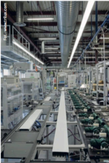
Fot. 3. Zastosowanie statecznika elektronicznego przy lampach wyładowczych oznacza podniesienie wydajności o ok. 15% w porównaniu do konwencjonalnych rozwiązań
