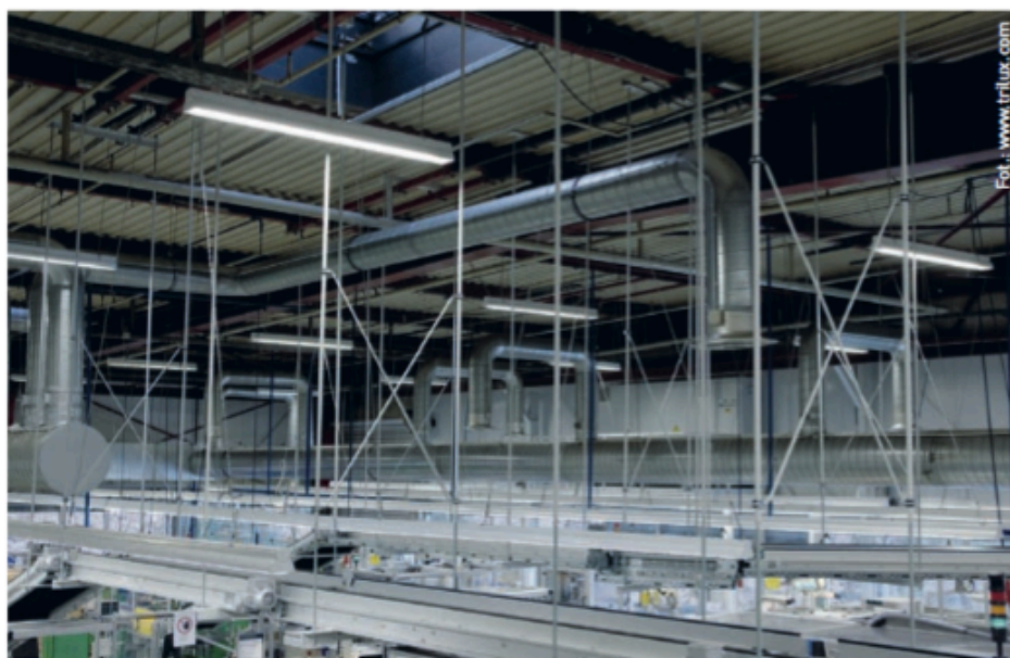
Fot. 2. Lampy wyładowcze polecane są zwłaszcza do wysokich pomieszczeń, np. hal magazynowych
