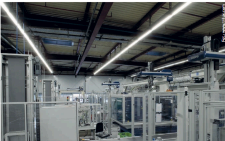
Fot. 1. Wysoka jakość oddawania barw sprawia, że wyładowcze źródła światła wciąż są wykorzystywane w zakładach produkcyjnych
