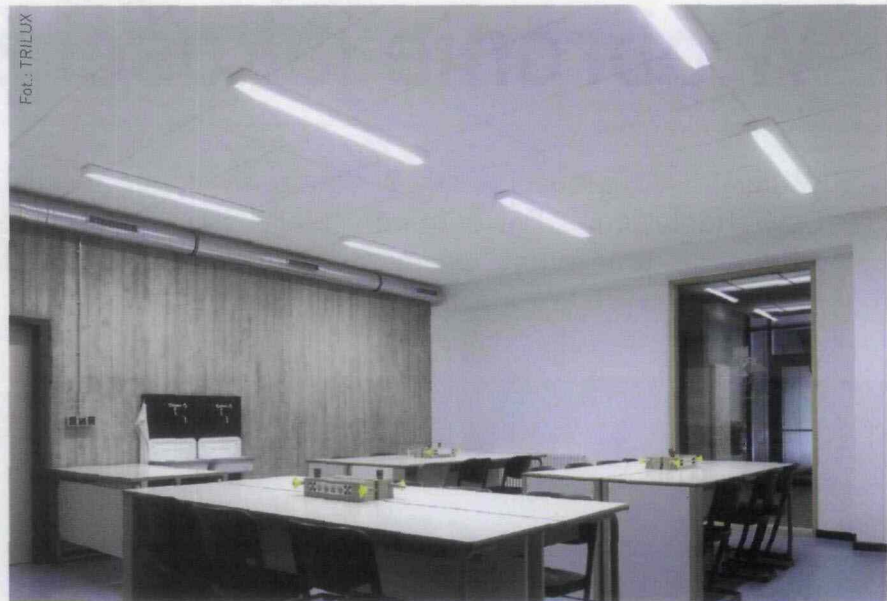
Fot. 7. Rastry to jedno z niewielu rozwiązań, które chronią użytkowników przed nieprzyjemnym zjawiskiem olśnienia
