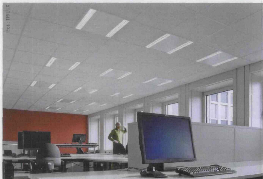
Fot. 8. Oprawy rastrowe z odbłyśnikiem parabolicznym polecane są przede wszystkim do pomieszczeń przeznaczonych do pracy z ekranem komputera
