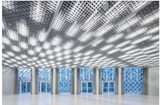
[Foto: ELine_0_171203_039.jpg] Im Gebäudeinneren fungiert eine Lichtdecke gleichzeitig als Flächenbeleuchtung für das Foyer sowie als riesiger Mediascreen.
