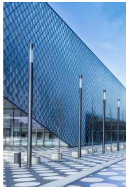
[Foto: Constela_0_171203_006.jpg] Die Beleuchtung der Vorplätze und der fassadennahen Zonen an den Längsseiten des Gebäudes übernehmen die Lichtstelen Constela LED von TRILUX.
