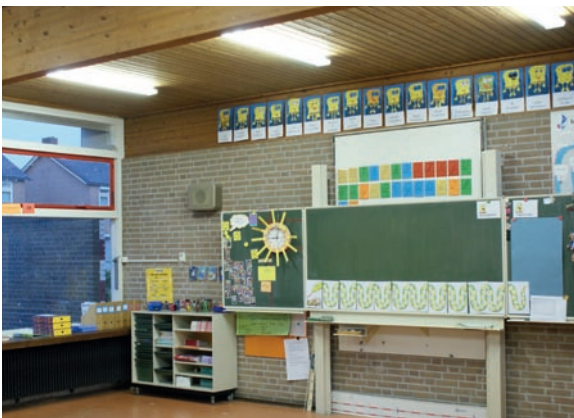
Voorbeeld van klaslokaal met verouderde verlichting: kale montagebalken sturen het licht naar alle richtingen.
