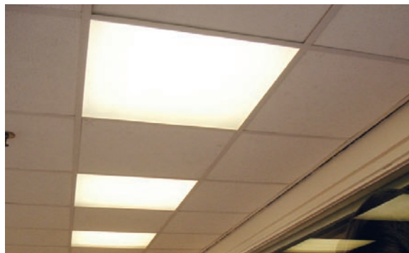
Inbouwarmatuur met prismakap.
