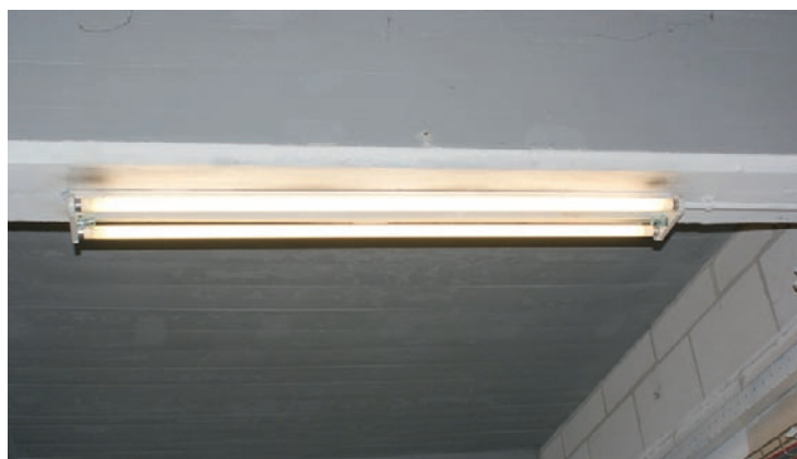
Een kale montagebalk zonder reflector stuurt het licht naar alle richtingen.
