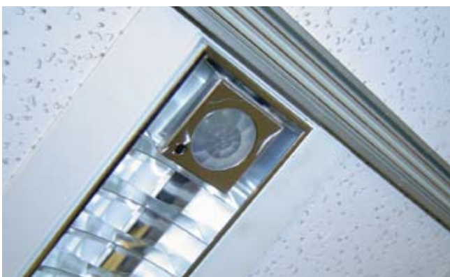
Toepassing combinatie van aanwezigheidssensor met lichtsensor
